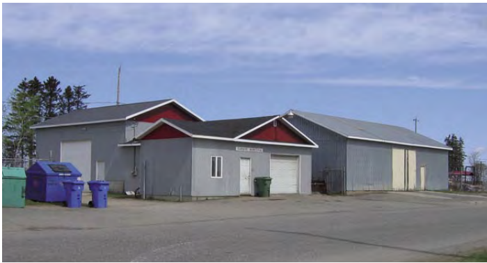
L'actuel garage des Travaux publics est constitué d'un ensemble hétéroclite de bâtiments qui ne répondent plus aux exigences d'une gestion efficace et sécuritaire.
